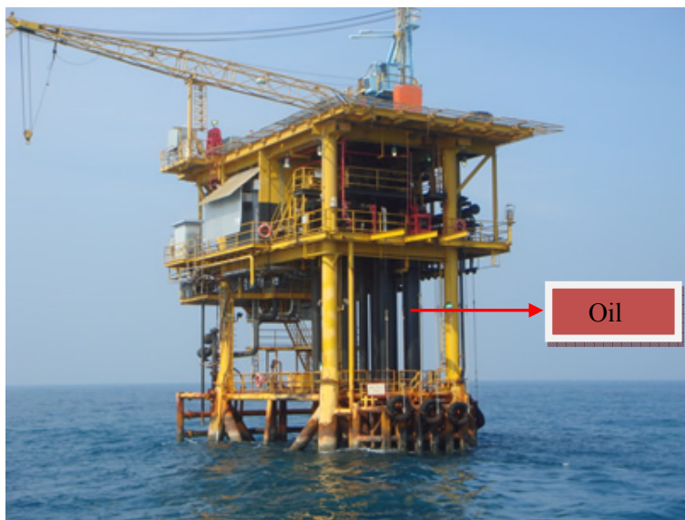
تصویر ۴ نمای لوله Riser
